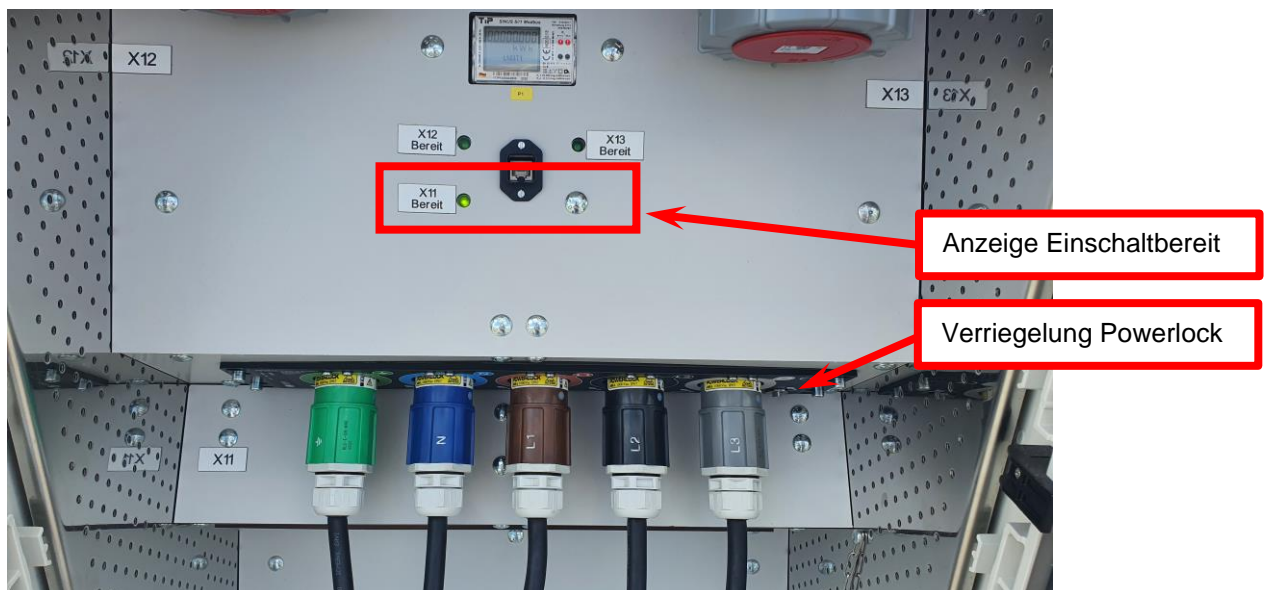
Bild 6: Powerlock verriegeln und einschaltbereit
