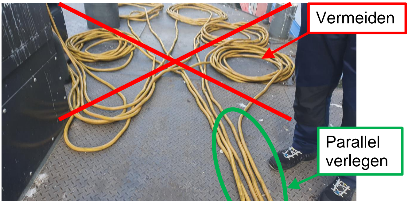
Bild 13: Verlegung von Einzeladern
